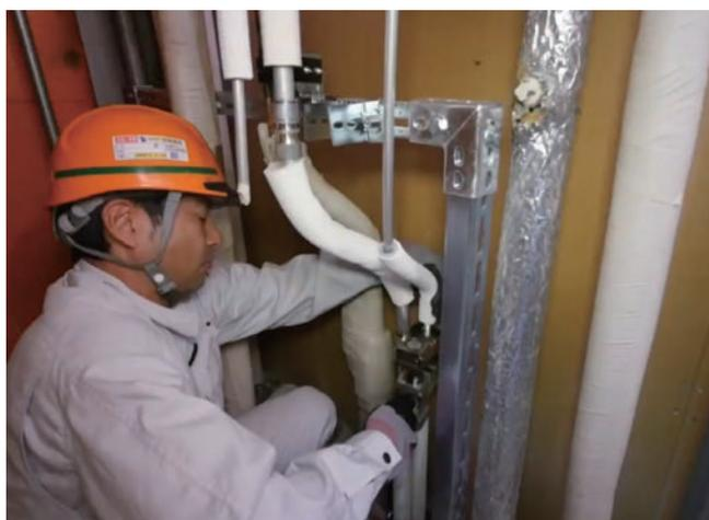
4階建て事務所ビルの空冷ヒートポンプパッケージエアコン(冷房能力50kW、暖房能力56kW)に対して施工した事例です。配管サイズは25.4φ、12.7φ、配管長さは80mです。縦管の長さは約14mです。狭いシャフト内でも縦管の施工がスムーズに行えました。
