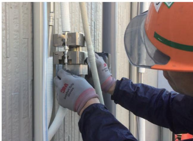
2階建て事務所のペアタイプ空冷ヒートポンプパッケージエアコン(冷房能力7.1kW、暖房能力8.0kW)6系統に対して施工した事例です。配管サイズは15.8φ、9.5φ、1系統当たりの配管長さは10mです。アルミ配管は、加工性が良く、継手形状がスリムなため、天井内、配管カバー内など納まりよく施工できました。
