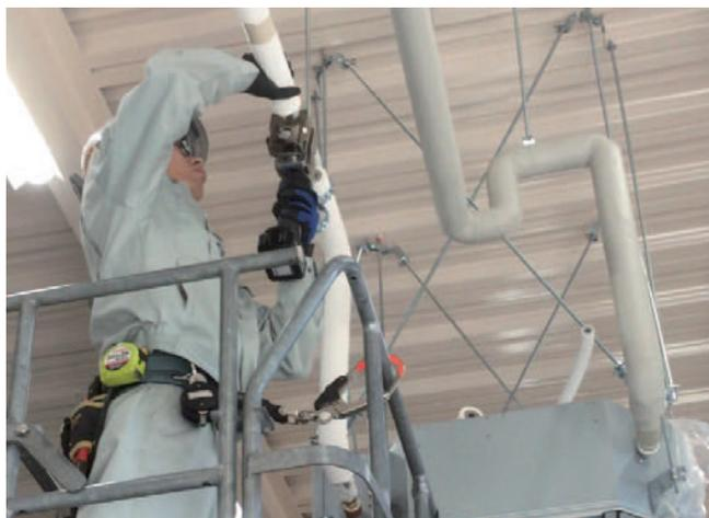
2階建て延床1,900㎡の工場のマルチタイプ空冷ヒートポンプパッケージエアコン(冷房能力25kW、暖房能力28kW)に対して施工した事例です。配管サイズは25.4φ、15.8φ、配管長さは100mです。軽量のアルミ配管、プリセット化した継手により工期の短い現場で迅速に施工ができました。
