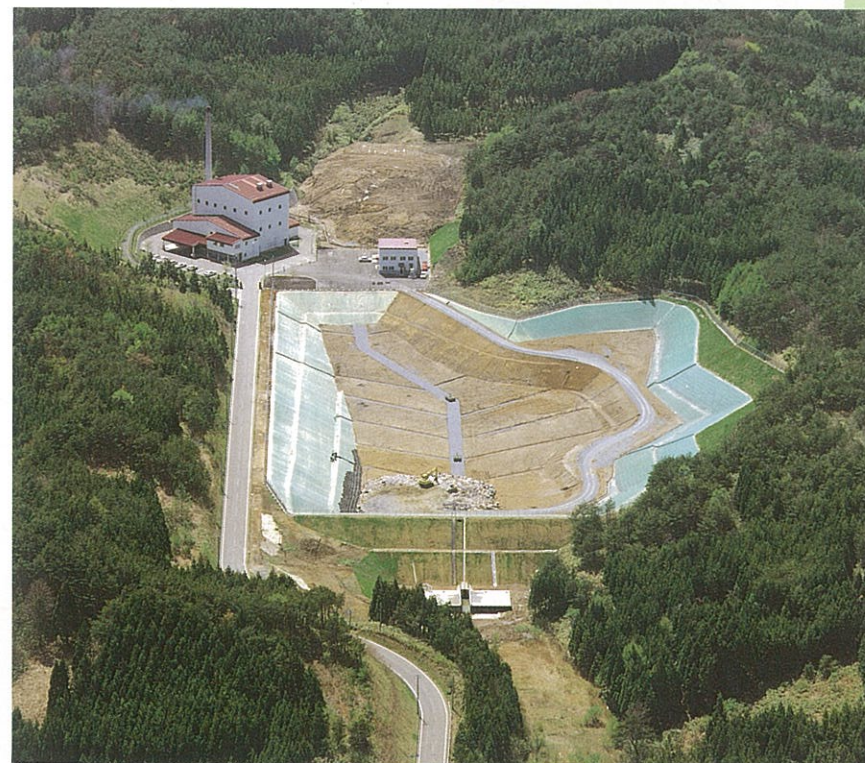
最終処分場施設
