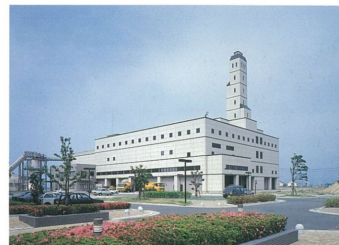
流動床式汚泥焼却施設
