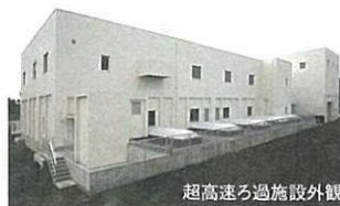
超高速ろ過施設外観
