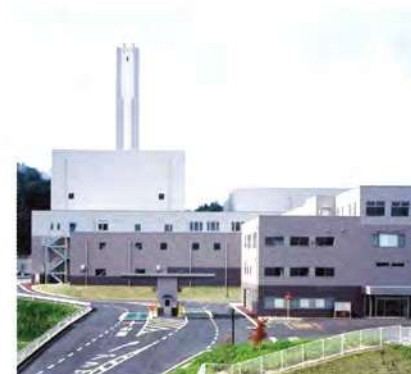
伊賀南部クリーンセンター 所在地 三重県伊賀市奥鹿野1990番地 焼却炉形式 流動床式ガス化溶融炉 施設規模 焼却施設 95t/24H リサイクル施設 45.5t/ 5H 竣工年 H21/ 2
