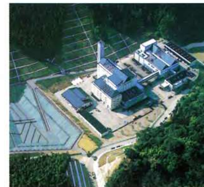
日置地区塵芥処理組合クリーン・リサイクルセンター 所在地 鹿児島県鹿児島市入佐町2319番地 焼却炉形式 准連続燃焼式ストーカ方式 施設規模 焼却施設 81t/16H リサイクルプラザ 25t/ 5H 竣工年 H11/ 3
