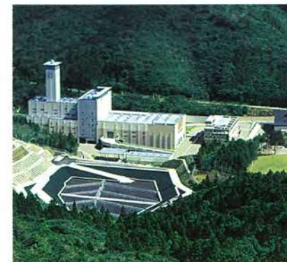
対馬クリーンセンター 所在地 長崎県対馬市岐原町安神141 焼却炉形式 流動床式ガス化溶融炉 施設規模 焼却施設 60t/24H リサイクルプラザ 21t/ 5H 浸出水処理施設 60m³/日 竣工年 H15/ 3
