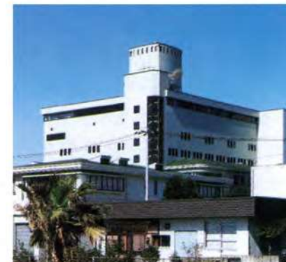
大村市清掃クリーンセンター 所在地 長崎県大村市森岡町1470番地 焼却炉形式 准連続燃焼式ストーカ方式 施設規模 焼却施設 111t/16H 粗大ごみ処理施設 25t/ 5H 竣工年 H9/12
