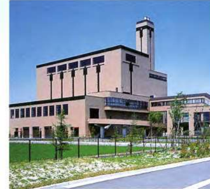
新発田広域クリーンセンター 所在地 新潟県新発田市藤掛625番地1 焼却炉形式 准連続燃焼式ストーカ方式 施設規模 127t/16H 竣工年 H10/ 3
