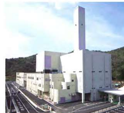
鳴門市クリーンセンター 所在地 徳島県鳴門市瀬戸町堂浦字浦地105番地17-2 焼却炉形式 流動床式ガス化溶融炉 施設規模 焼却施設 70t/24H 竣工年 H20/ 3
