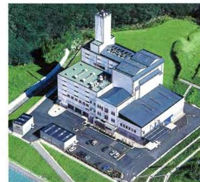
上五島広域クリーンセンター・施設ごみ焼却施設 所在地 長崎県南松浦郡上五島町網上郷字熊高813-3 焼却炉形式 准連続燃焼式ストーカ方式 施設規模 焼却施設 60t/24H リサイクルプラザ 21t/ 5H 竣工年 H14/12
