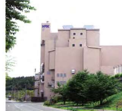
ナリコークリーンセンター(第三工場) 所在地 千葉県成田市十余三子天神峰214-62 焼却炉形式 三機水冷ストーカ方式 施設規模 90t/24H 竣工年 H23/ 9
