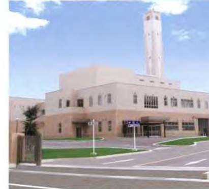
八郎湖周辺クリーンセンター 所在地 秋田県男鹿市松木沢字板引沢73番地 焼却炉形式 三機水冷ストーカ方式 施設規模 焼却施設 60t/24H リサイクル施設 15t/ 5H 竣工年 H20/ 3
