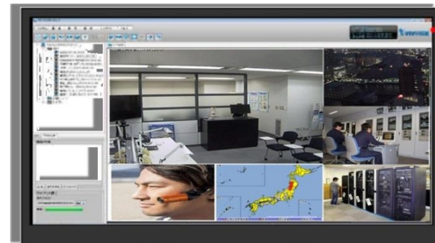
危機管理センター側 モニタリング状況例
