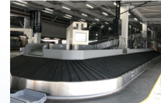
成田国際空港 第1ターミナル南棟
