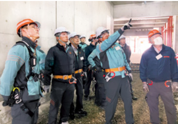
施工現場視察
