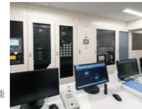
ビルの管理中枢機能を担う中央監視室
