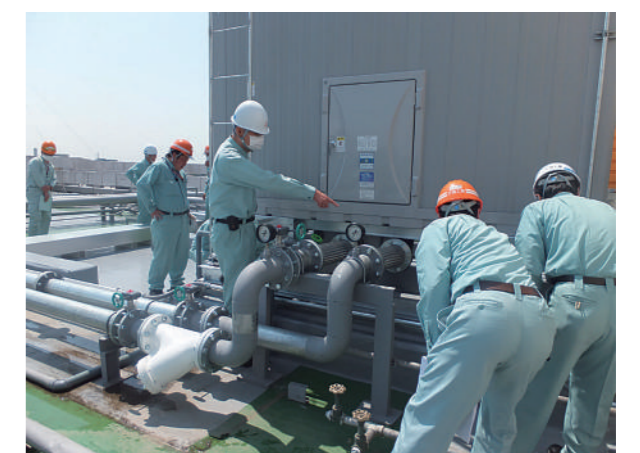
「技術エキスパート」による施工監査
