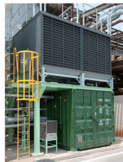
小型バイナリー発電設備
