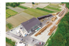
木質バイオマスガス化発電設備
