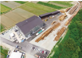
木質バイオマスガス化発電設備
