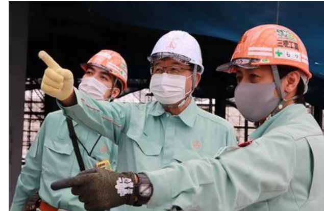
安全衛生パトロール
