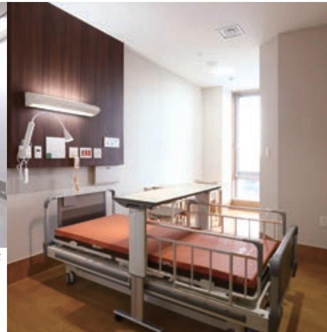
▲手術室・病室ともBEMS（ビルエネルギーマネジメントシステム）の中央監視設備による、自動制御を実現
