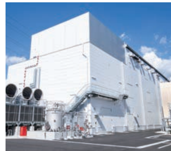
▲京都工場7号棟外観
