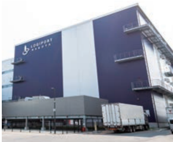
▲ロジポート名古屋外観
