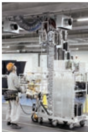
▲ロボットを用いた工法
