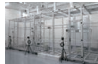
▲極低湿度環境試験室(低露点ブース外観)
