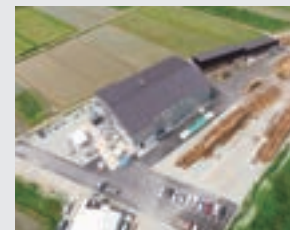
木質バイオマスガス化発電設備
