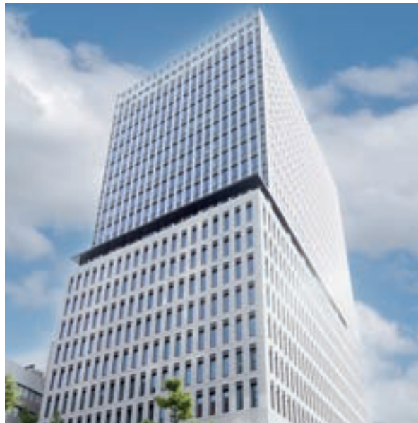
▲アーバンネット御堂筋ビル外観
