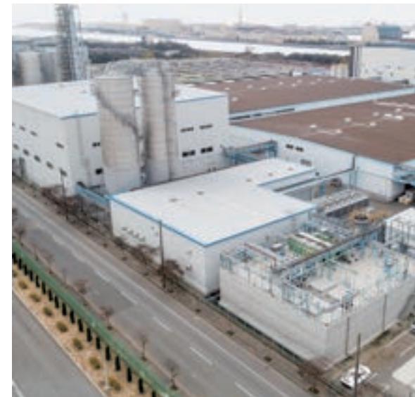
▲遠東石塚グリーンペット姫路工場の全景(手前が排水処理設備)
