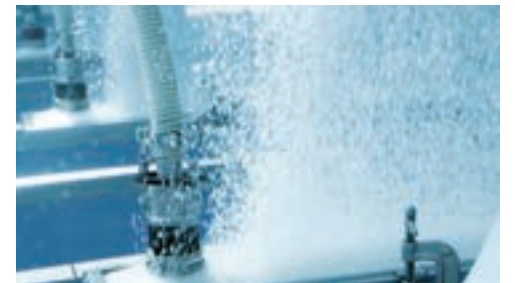
▲散気装置によるばっ気
