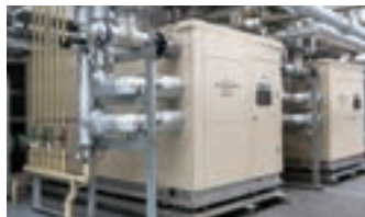
▲ガス焚き吸収式冷温水発生機
