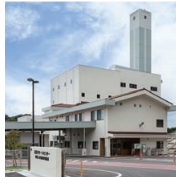
▲邑智クリーンセンター可燃ごみ共同処理施設の外観
