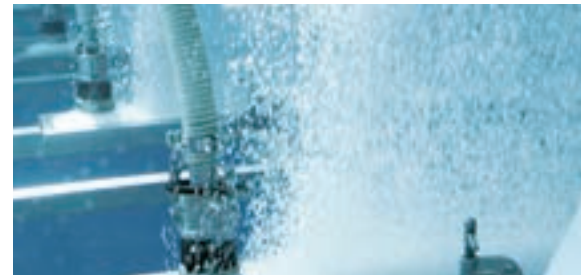
▲散気装置設置状況
