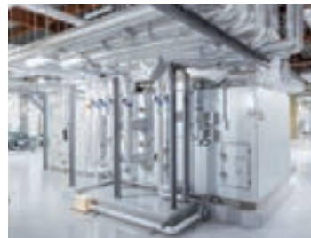
▲外気処理空調和機(外調機)
