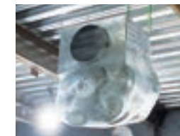
▲ユニット化して搬入したチャンバーとダクト
