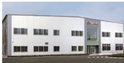
大和プロダクトセンター概要 所在地 : 神奈川県大和市中中央林間7-12-1 構造 : S造 階数 : 地上2階 延床面積 : 7,611㎡
