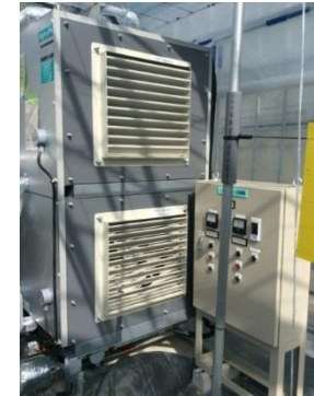
fan coil unit (FC)
