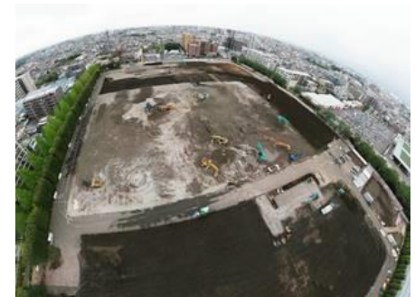
旧大和事業所解体風景
