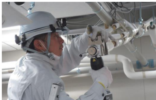
アルミニウム冷媒配管工法 「アルミンジャー工法」の 市場展開
