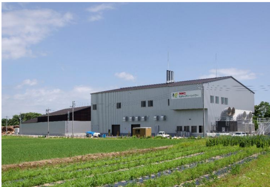
プラント建屋外観
