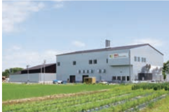
▲木質バイオマスガス化発電施設外観 (右：発電所、左：チップ工場)
