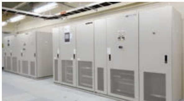
▲無停電電源装置（UPS：Uninterruptible Power Supply）
