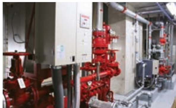
▲地下2階にあるポンプ室。手前がスプリンクラーポンプ
